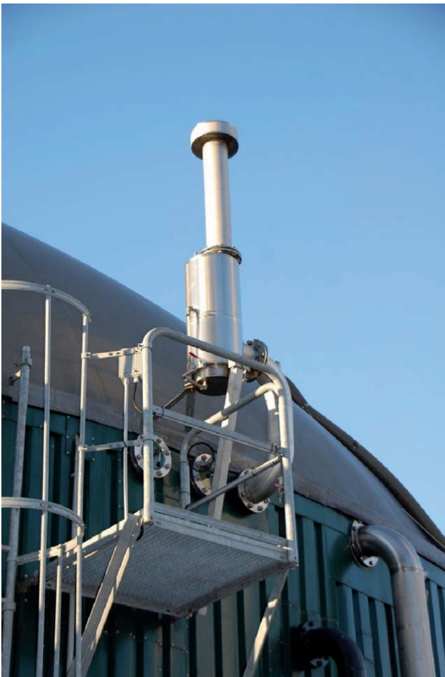
Bild 3: Über-/Unterdrucksicherung Fermenter
